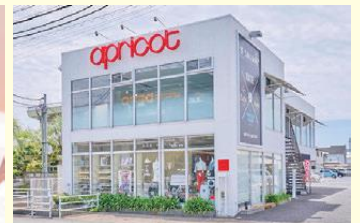
▲外観(オークワ橿原常盤町店さん敷地内 2階)
